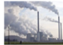
Centrales électriques gaz/oil
